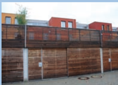
Garagen für Pkw und zusätzliche Abstellfläche
