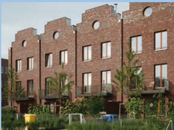
Baugruppe „New Rummelsburg“, Berlin
