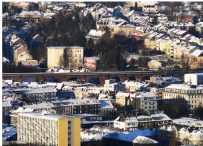
Abb. 6: Das Viadukt der Nordbahntrasse im Wuppertaler Stadtgebiet (Foto: Atamari)
